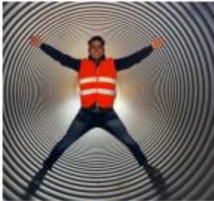
Zeer eenvoudig te inspecteren en reinigen - toegankelijk
